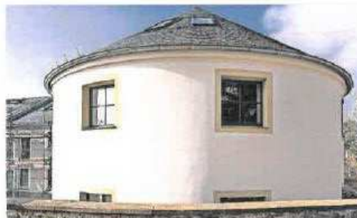
... und nach dem Umbau. In diesem Teil des Rittergutes entstanden zwei Wohnungen. Sie werden im April bezogen.
