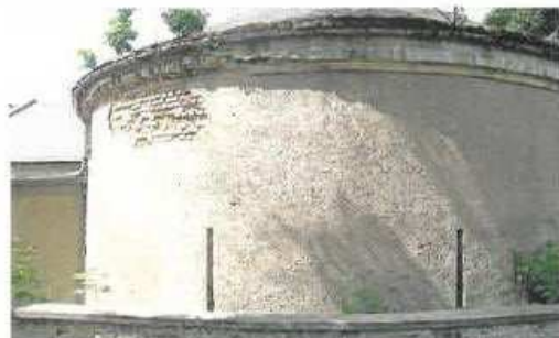
Das dem Hotel „Kyffhäuser“ zugewandte Rondell des Rittergutes vor der Sanierung ... Foto: Walther & Partner GmbH Dresden
