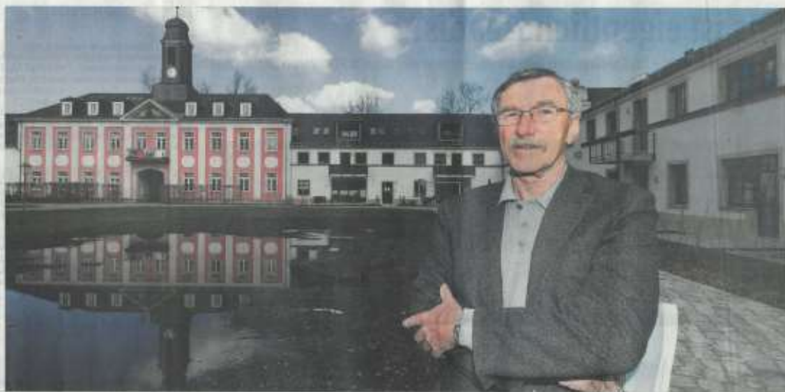
Die Gesamtanlage des Großharthauer Ritterguts mit dem großzügigen Innenhof und der dazugehörigen Parkanlage hat durchaus Schlosscharakter. Dass der Ostflügel über Jahrhunderte als Wirtschaftsgebäude und Scheune genutzt wurde, ist nach der Sanierung kaum noch vorstellbar. Das war auch Ziel des Investors Jochen Walthert. Foto: Jochen Walthert
